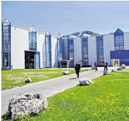
Die Pankl-Fertigung in Kapfenberg wird um 2700 Quadratmeter erweitert. Mit dem Bau wurde gestern begonnen
